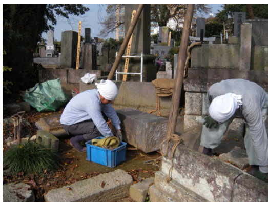
下に落ちた棹石(さおいし)を傷つけずに持ち上げながら、慎重に作業を進めます。
