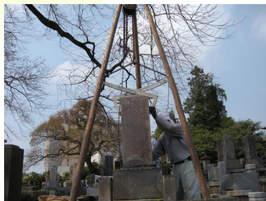
剥がれてしまった古い接着部分をきれいにし、きちんと水平を測りながら、ふたたび接着し直し、固定していきます。
