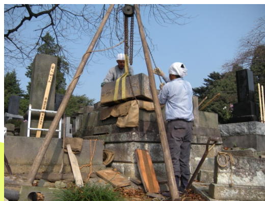
クレーンの代わりに、3本の柱で支えながら、チェーンを使って吊り上げていきます。
